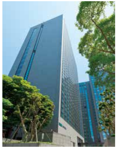
MS&ADホールディングスが2014年10月に移転する東京住友ツインビルディング(新川ビル)
