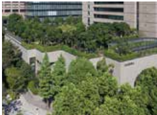
駿河台ビルの屋上庭園
