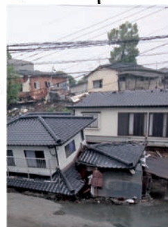
地震による倒壊
